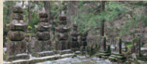
▲墓地・石塔修復前
