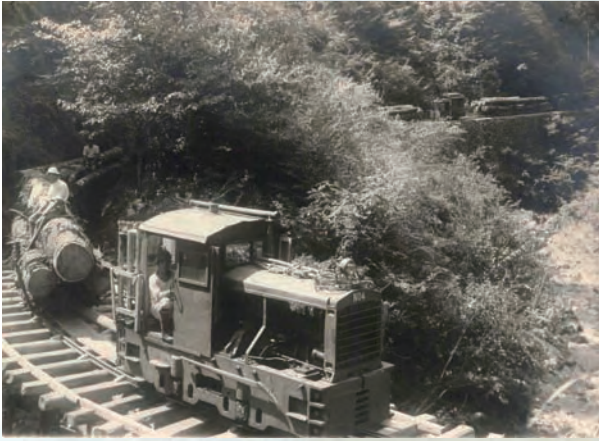
当時国有林では機関車で運材をしていました。
