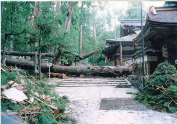
平成10年の台風7号での奥の院御供所。
